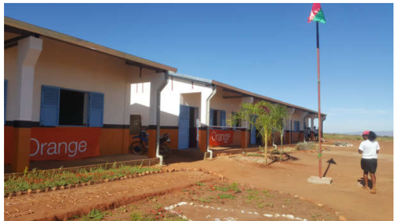
Le nouveau lycée
